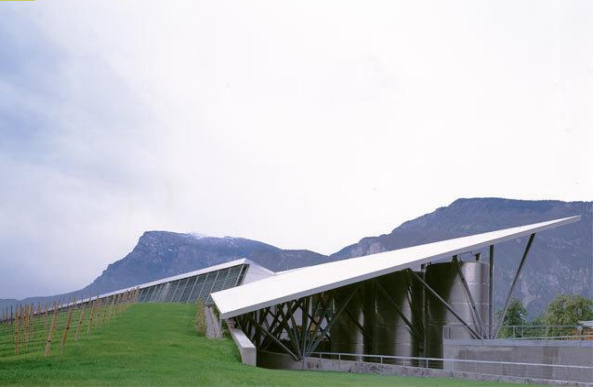
**struttura verticale** concepita come un grande laboratorio di oltre **6.000 mq.** Sviluppo su **4 livelli** per la **movimentazione delle uve e del mosto solo per caduta**, senza l'ausilio di pompe né di altri mezzi meccanici.
