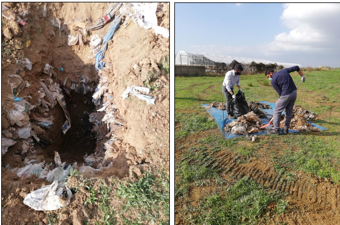
Figura 9 - Fasi di campionamento dei cumuli di rifiuto.
